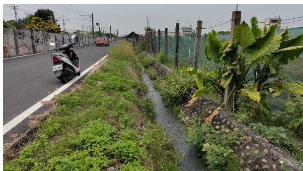
說明：永靖重劃區中排 7
