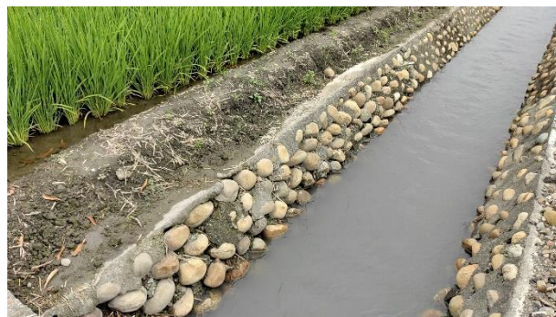
說明：永靖重劃區中排 7
