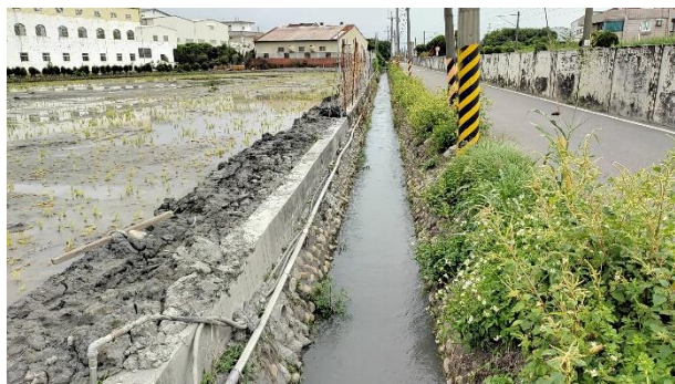
說明：永靖重劃區中排 7
