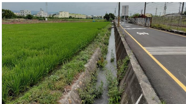
說明：永靖重劃區中排 7
