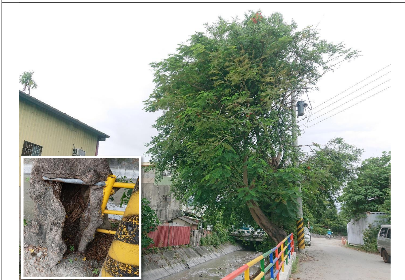
說明：約0+031K 處約十米高鳳凰木，無樹穴，生長環境不佳
