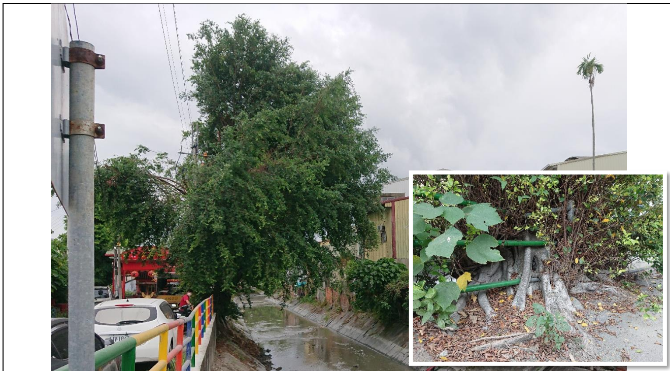
說明：約0+031K 處約十米高榕樹，無樹穴，生長環境不佳
