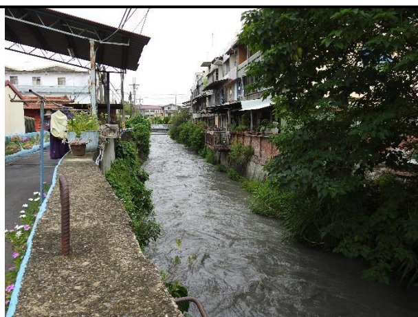
說明：渠道現況
