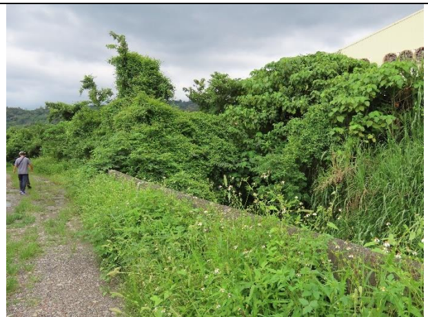
說明：渠道現況
