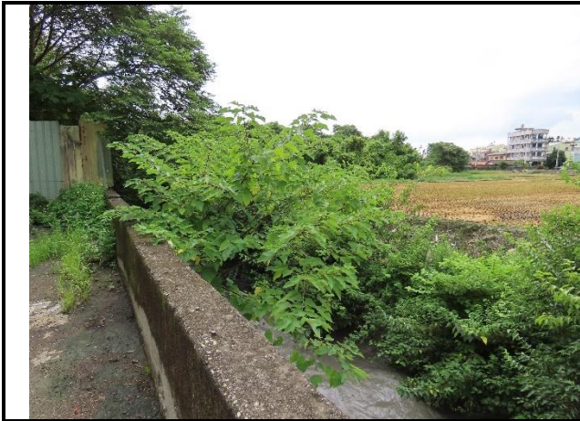
說明：渠道現況
