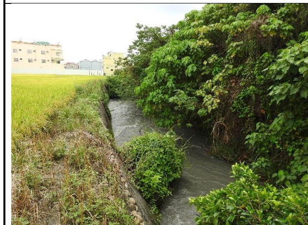
說明：渠道現況
