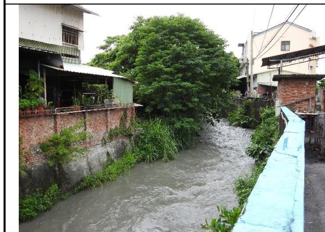
說明：渠道現況
