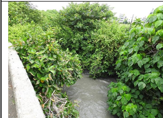
說明：渠道現況
