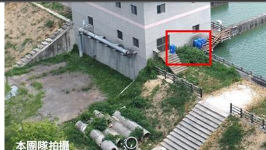
⑨ 機房外部分步道有 1 米高的落差，未完整串聯。階梯兩側也缺乏欄杆，亦有墜落等安全疑慮。
