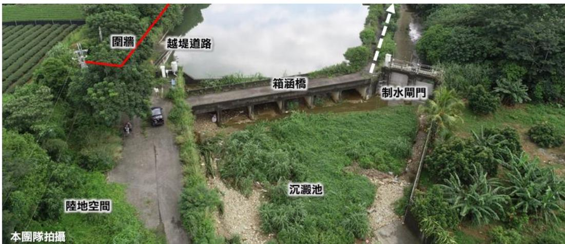
③ 靠近貯水池側有長約 20 公尺的腹地可作停留、機具迴轉空間。並由箱涵橋銜接至制水閘門，再由維護道路可通往溢流道。
