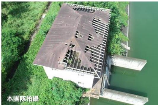
⑤既有機房總共有 3 處(上、中、下)，屋頂皆為木結構上方鋪設可樂瓦片，因年久失修已多處破損，其中又以中池的屋頂破損最多。破損處造成雨水直接貫穿屋頂，天花板多處積水狀況，積年累月後恐造成漏水、結構安全等問題，屬急迫改善程度。
