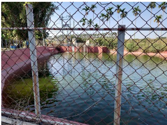
時間：112 年 11 月 17 日 說明：P18 池屬不透水蓄水池
