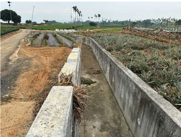
時間：112 年 5 月 20 日 說明：P14 至 P16 池沿線管線更換預定地
