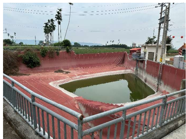
時間：112 年 5 月 20 日 說明：P16 池施工前照片
