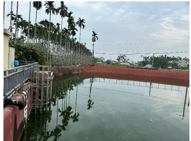
時間：112 年 5 月 20 日 說明：P18 池施工前現況
