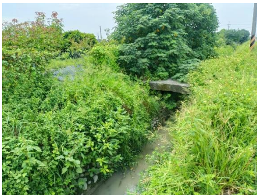
時間：114/8/28 說明：工程中間段，周圍雜木林
