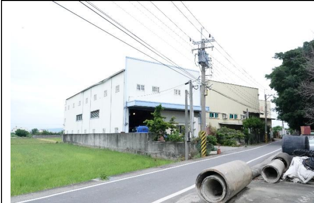
水尾支線環境照
