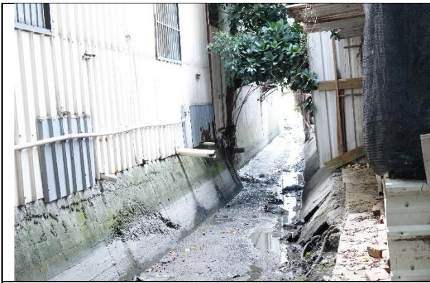
水尾支線環境照
