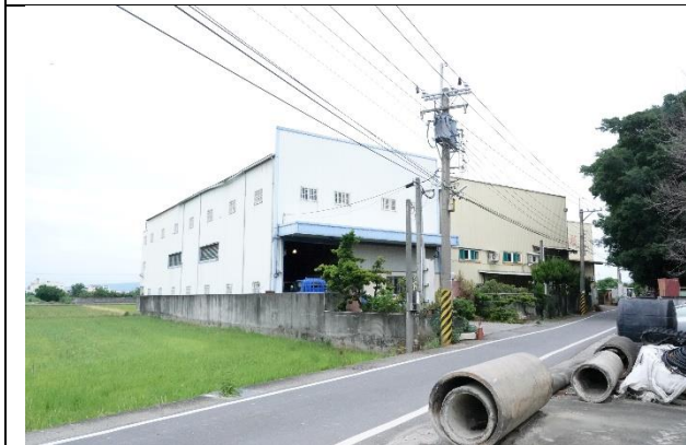
水尾支線環境照
