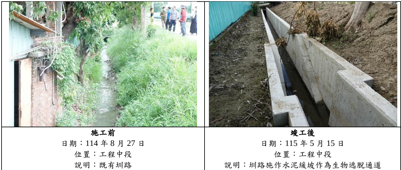
圖 25 王爺汴一支線四分線工程生物逃脫通道記錄照
