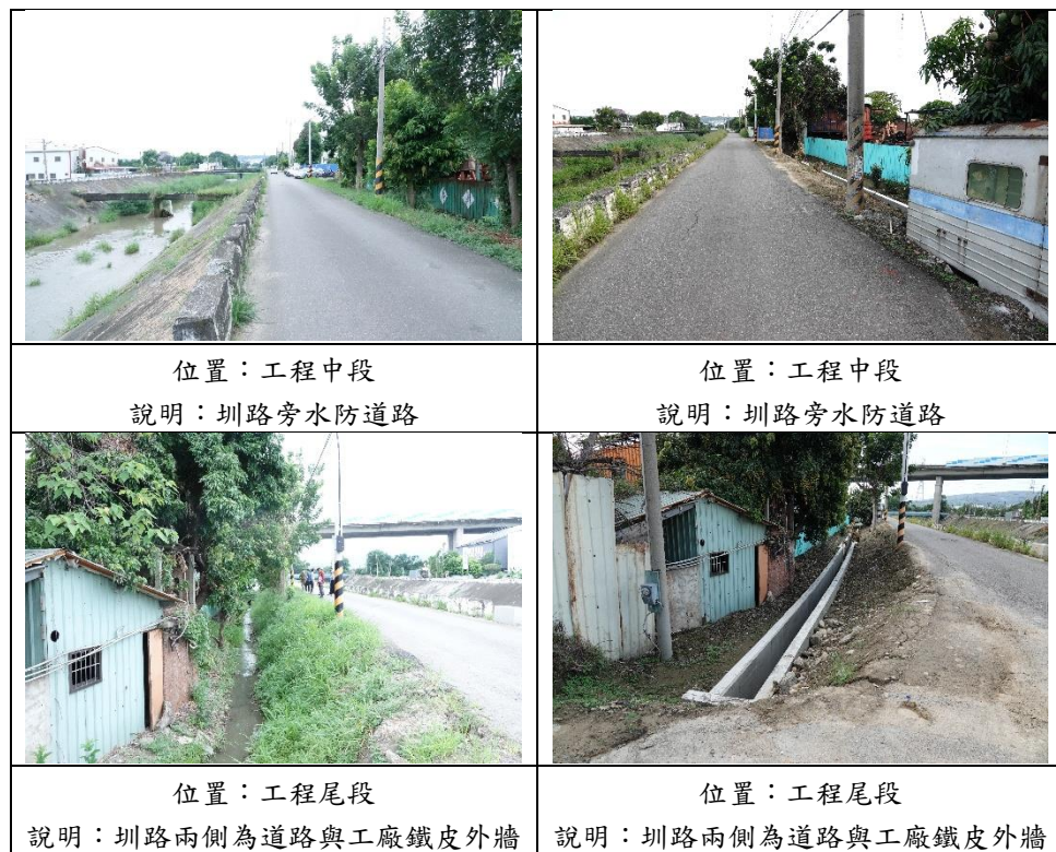
圖 24 王爺汴一支線四分線工程施工前後環境照
