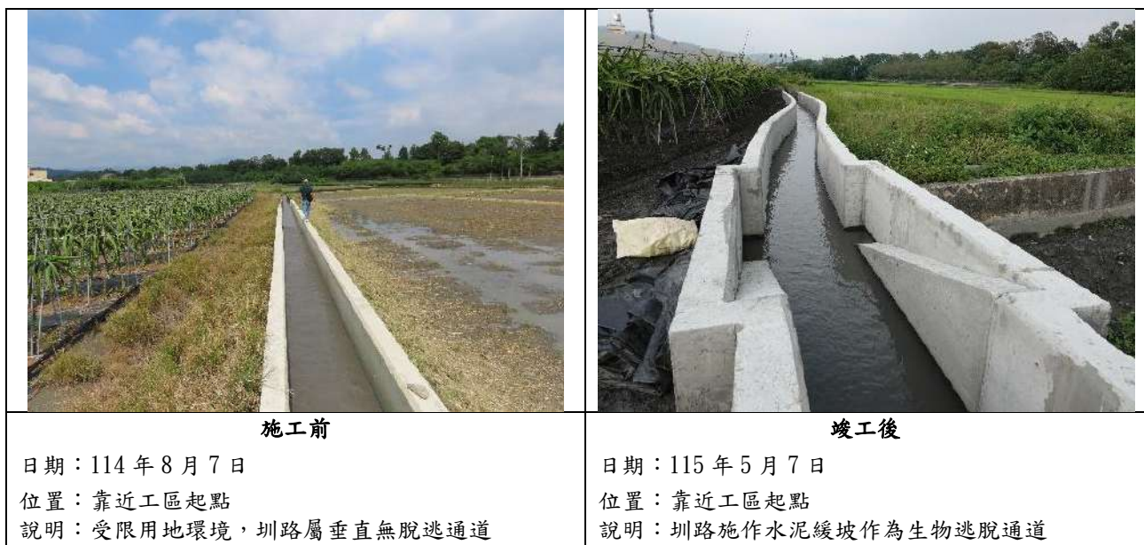
圖 23 南圳分線小給 4 改善工程生物逃脫通道記錄照
